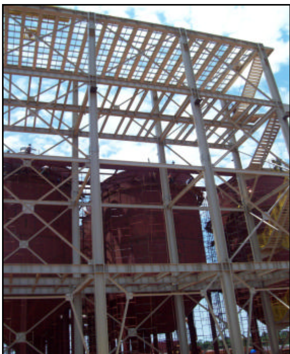
Construção da estrutura de moagem
