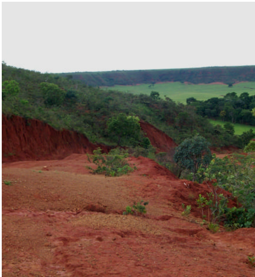
Foto 24. Processos erosivos na estrada de acesso a zona de uso especial.
