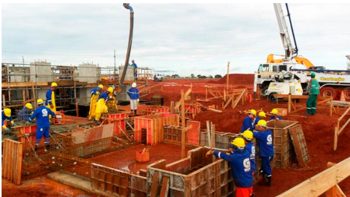
Figura 4 Prestadores de serviço realizando o bombeamento de concreto.
