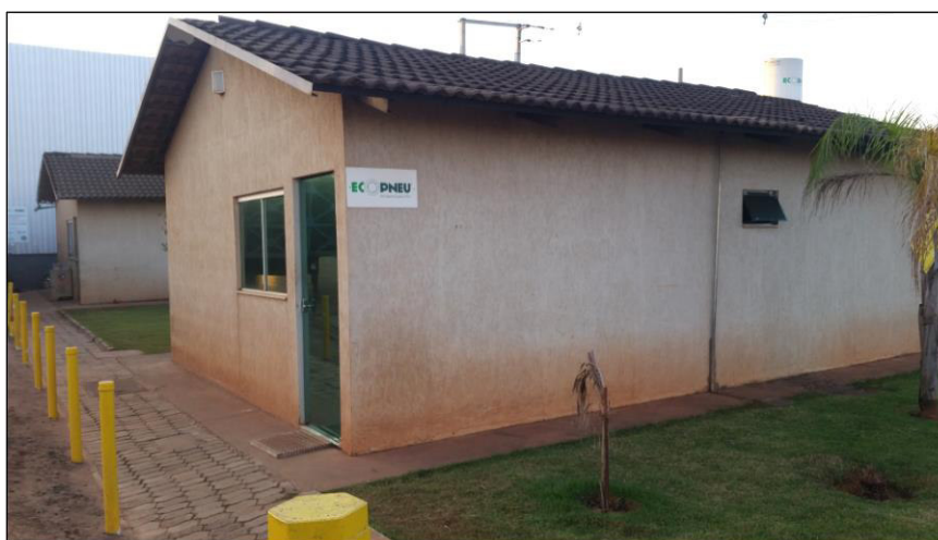
Figura 6 – Sede da Ecopneu construída com concreto com adição de pneus triturados
