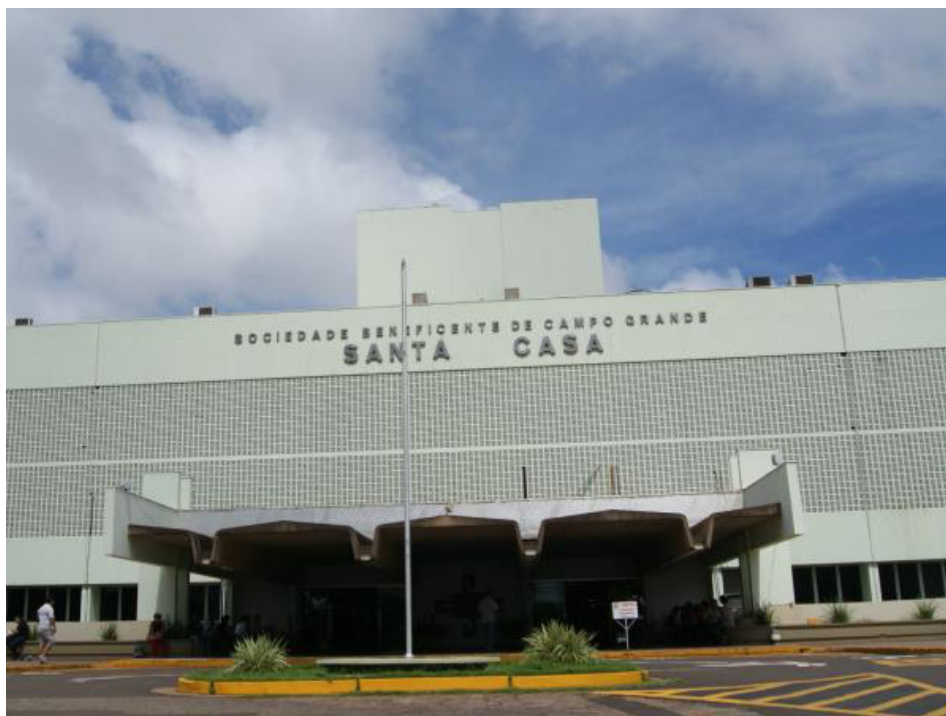
Foto nº 02: Frontispício principal da Santa Casa de Campo Grande
