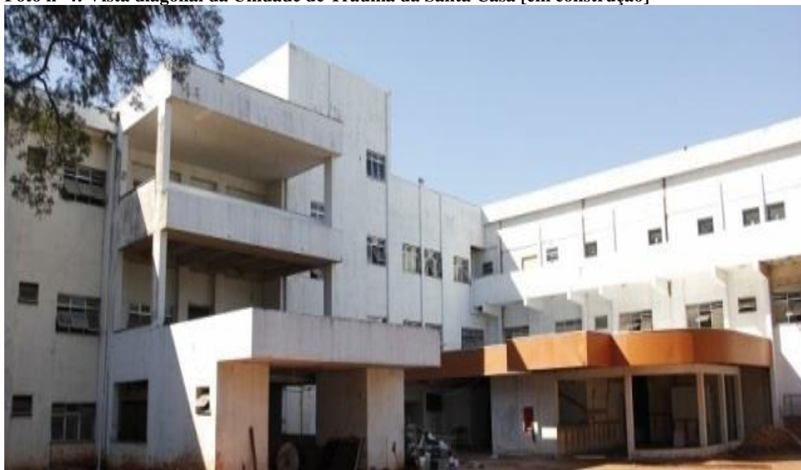
Foto nº 4: Vista diagonal da Unidade de Trauma da Santa Casa [em construção]
