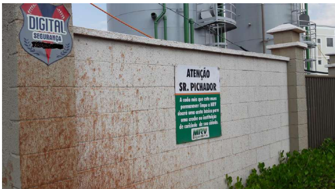
Muro de condomínio em Campo Grande (ARQUIVO PRÓPRIO, 2016)
