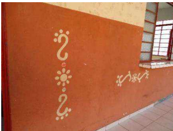
Parede da escola 1. Fonte: Cunha, 2016
