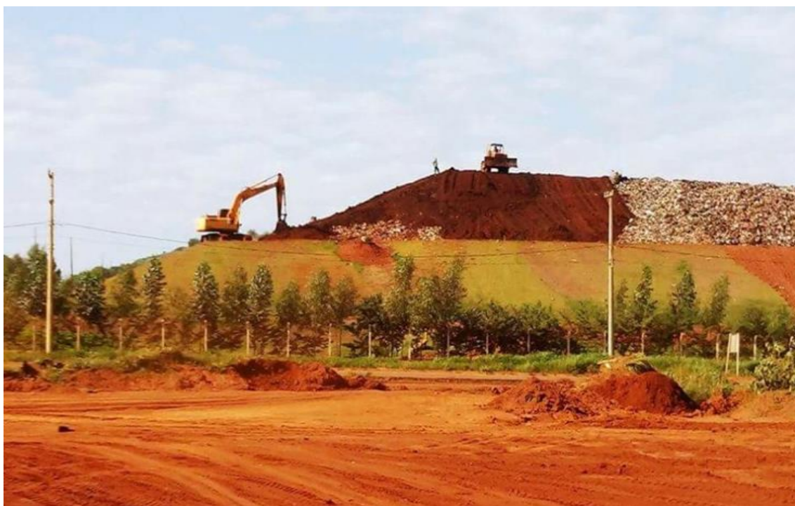
Figura 16 – Vista do aterro sanitário de Campo Grande/MS após reestruturação (2017)
