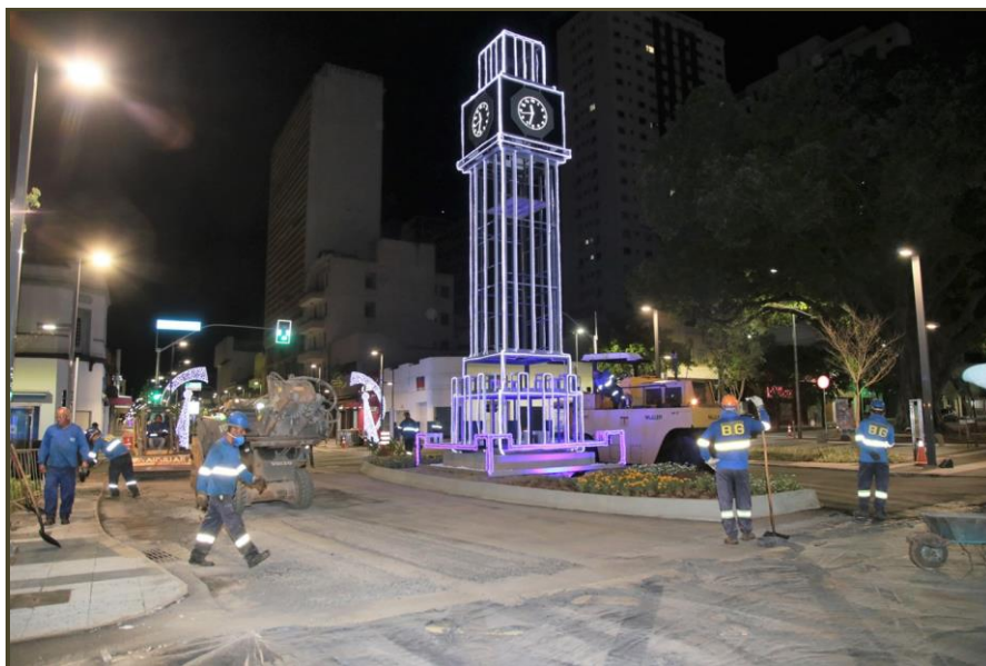
Foto 15 - Relógio da Rua 14 de Julho de Campo Grande - MS, em 2020
