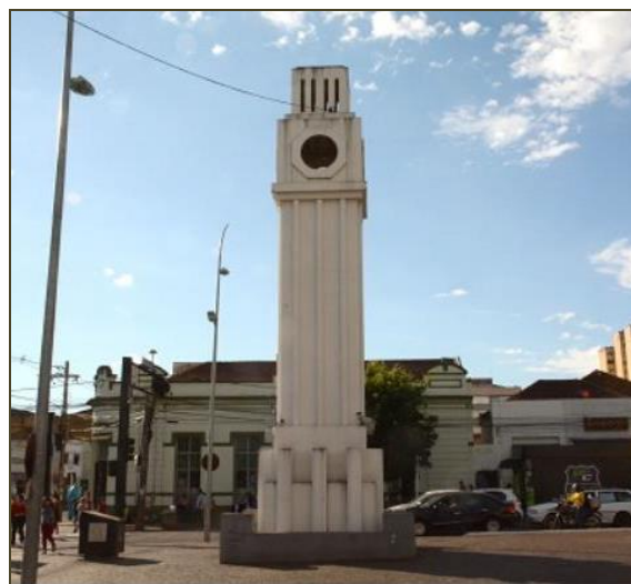
Foto 14 - Relógio da Rua 14 de Julho de Campo Grande - MS, em 1970
