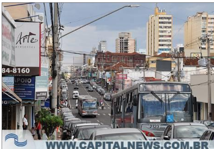
Foto 50 - Rua 14 de Julho - Campo Grande - MS
