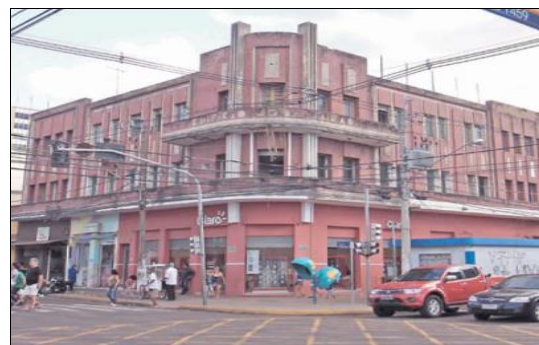
Foto 46 - Rua 14 de Julho, Prédio José Abrão, construído em 1939
