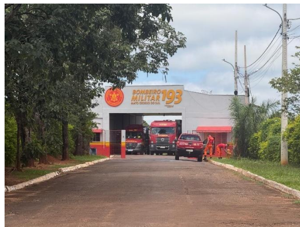
Figura 43 – Acesso ao Corpo de Bombeiros
