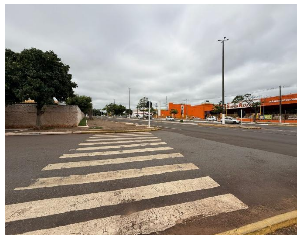
Figura 31 – Guia sem rebaixo na Rua Cel Juvêncio, na proximidade do Super Atacado Leve Max
