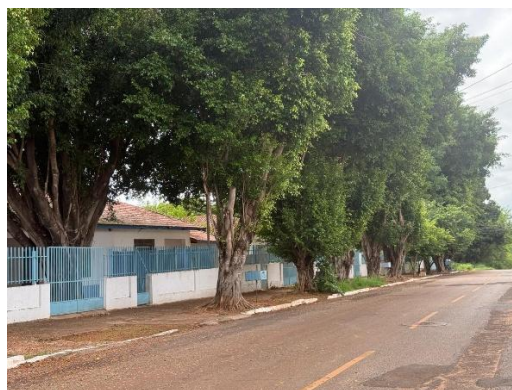
Figura 25 – Calçada na Rua Ten. Ari Rodrigues
