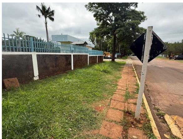
Figura 22 – Calçada em frente a 4ª Companhia de Engenharia de Combate Mecanizada
