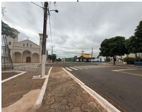
Figura 30 – Guia sem rebaixo na Rua Cel Juvêncio, na proximidade da Prefeitura Municipal
