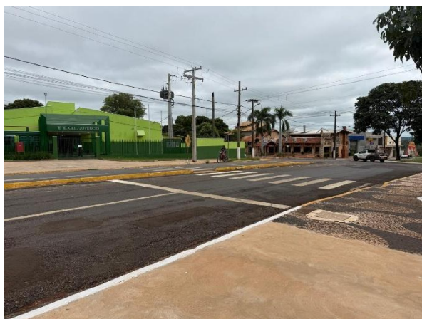
Figura 18 – Travessia de pedestre e calçada na Escola Estadual Cel. Juvêncio
