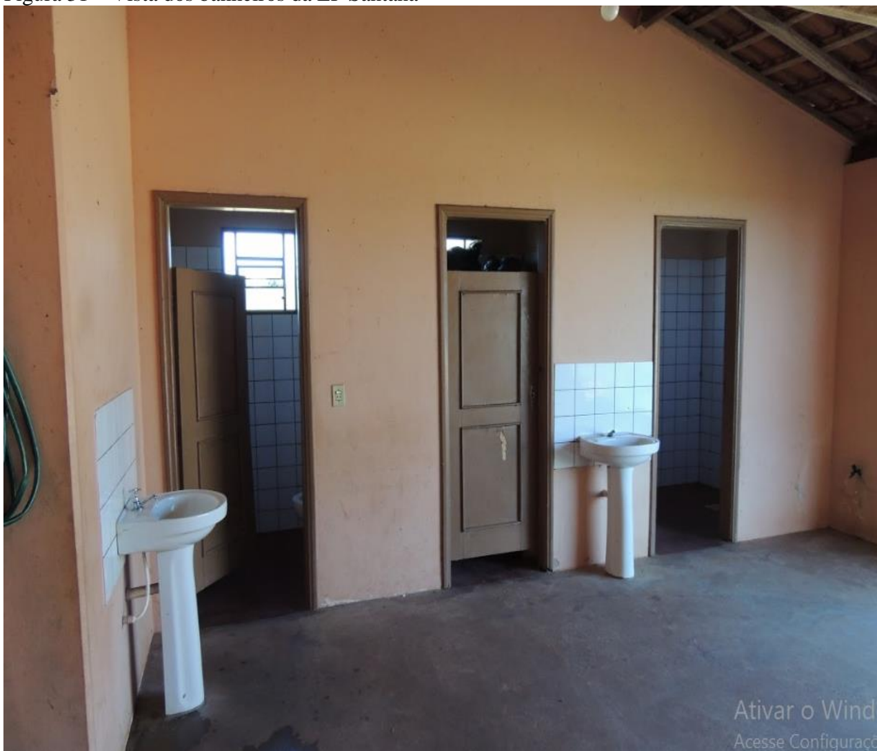
Figura 31 – Vista dos banheiros da EP Santana
