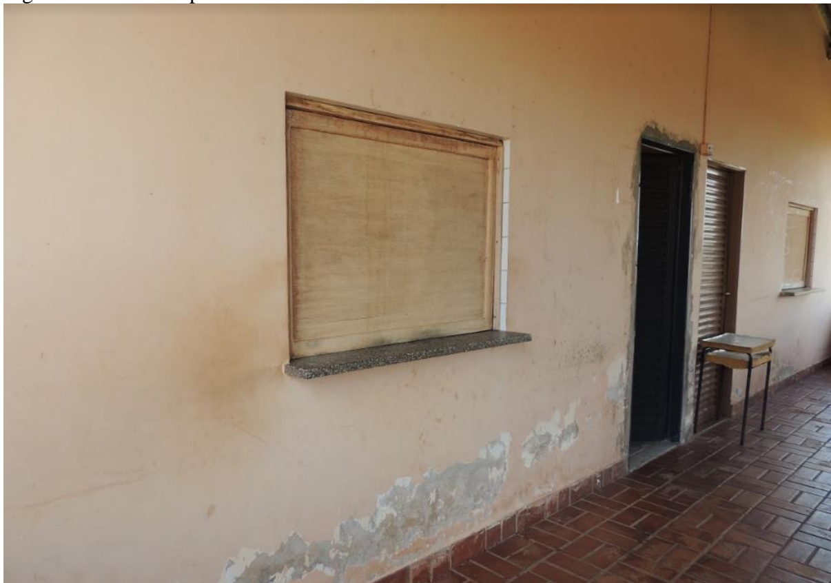
Figura 47 – Vista de parte do refeitório
