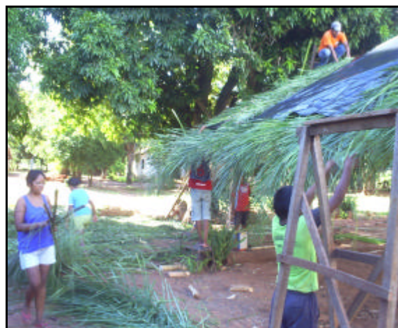
Foto 7 - Mutirão para a cobertura de uma varanda (B).
