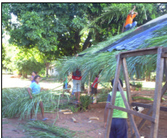
Foto 6 - Mutirão para a cobertura de uma varanda (A).
