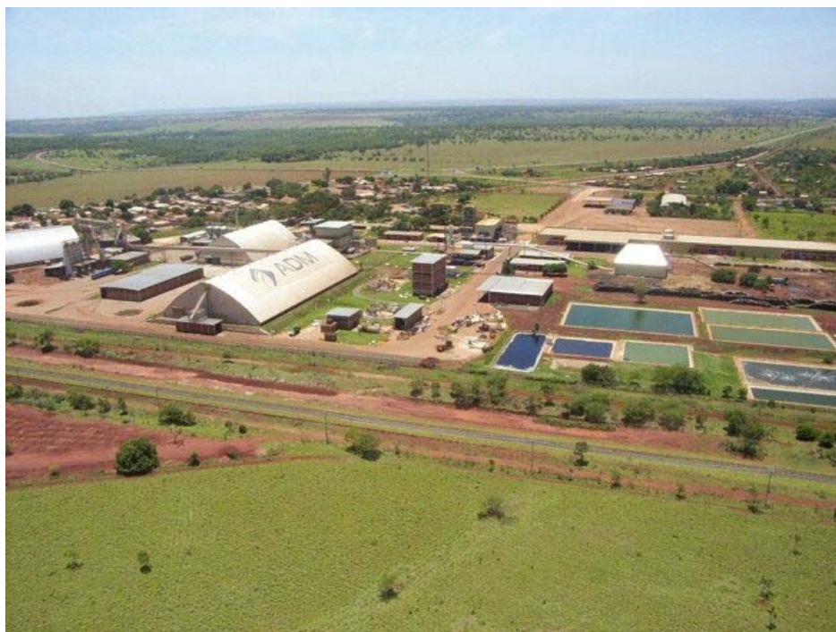
Foto 2 – Vista parcial do NICG sentido Sudoeste-Nordeste. Fonte: BACG, 2002.
