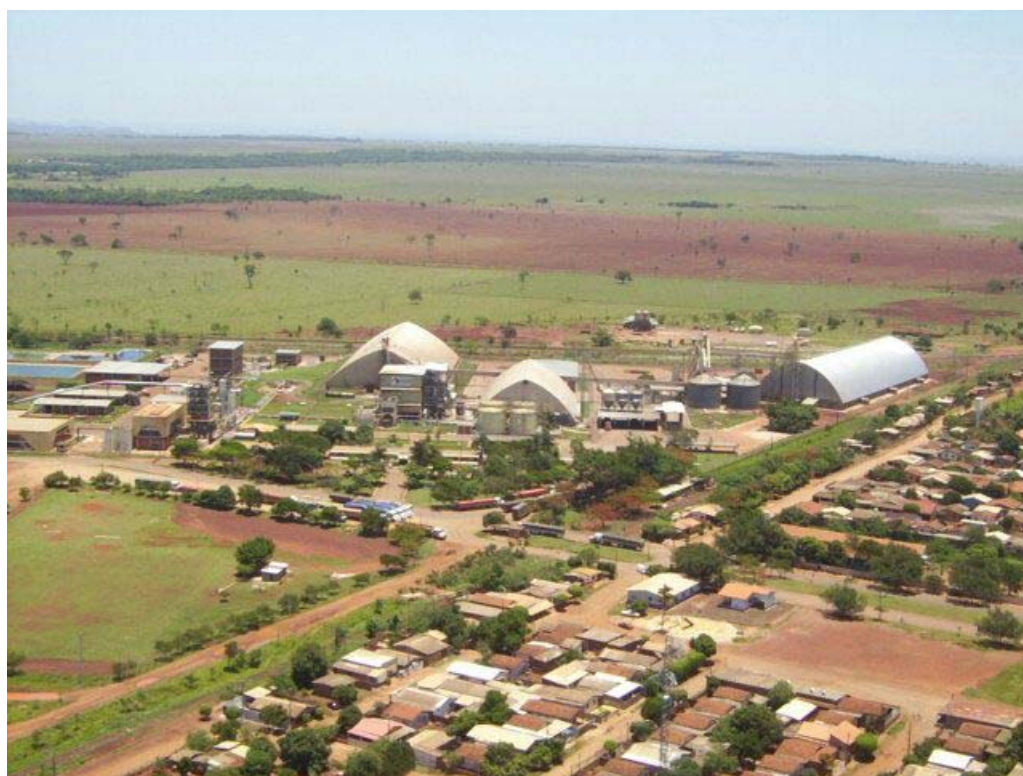
Foto 5 – Vista parcial do Conjunto Habitacional Manoel Secco Thomé. Fonte: BACG, 2002.
