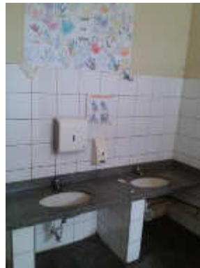
Figura 36 - Lavatório na Turma B
