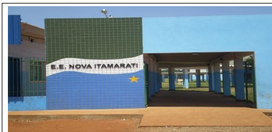
Figura 6 - Fachada da atual Escola Estadual Nova Itamarati
