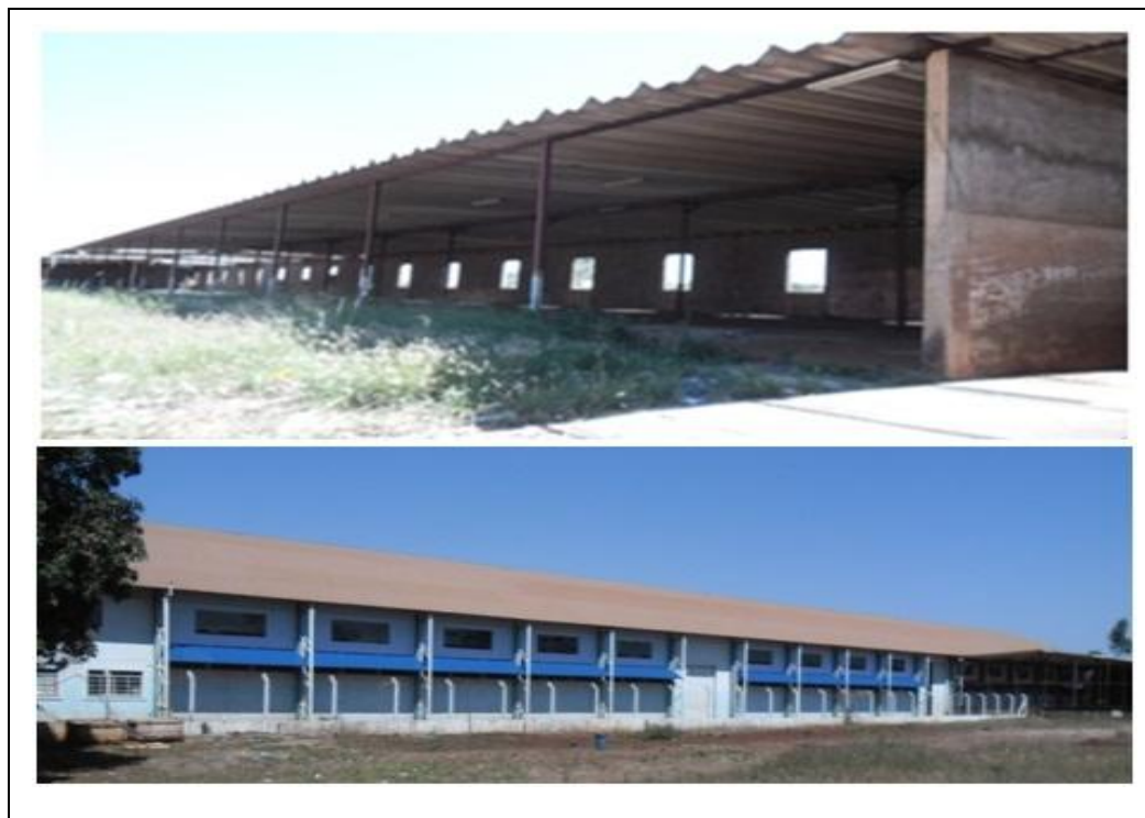
Figura 5 - Estrutura da antiga casa de máquinas e as salas atuais da Escola Estadual Nova Itamarati
