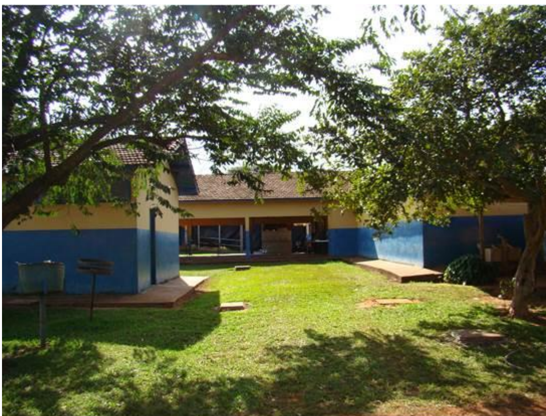
Pavilhões para aulas.
