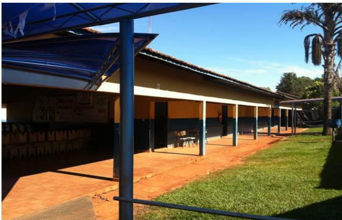
Pavilhão da Cozinha e Refeitório. Fonte: COSSATO, Marcio Beretta – 2013.
