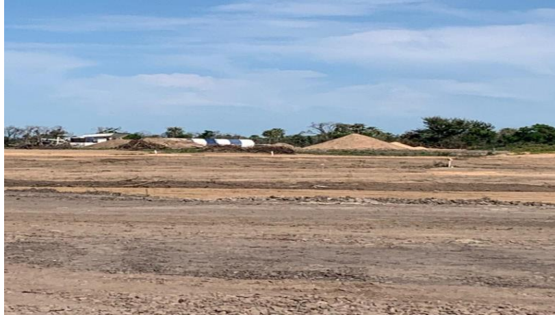
Figura 3 - Construção da ponte do lado Brasil – novembro de 2022.
