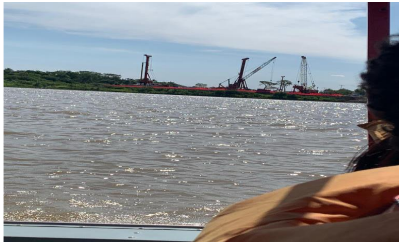
Figura 4 - Construção da ponte lado Paraguai – novembro de 2022.
