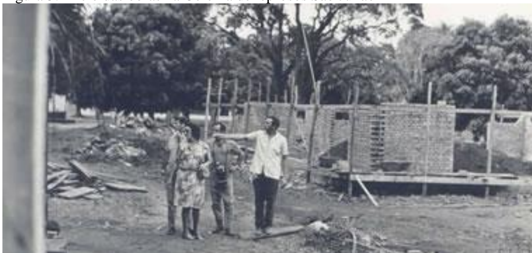
Figura 5: Início das obras na Colônia de leprosos São Julião
