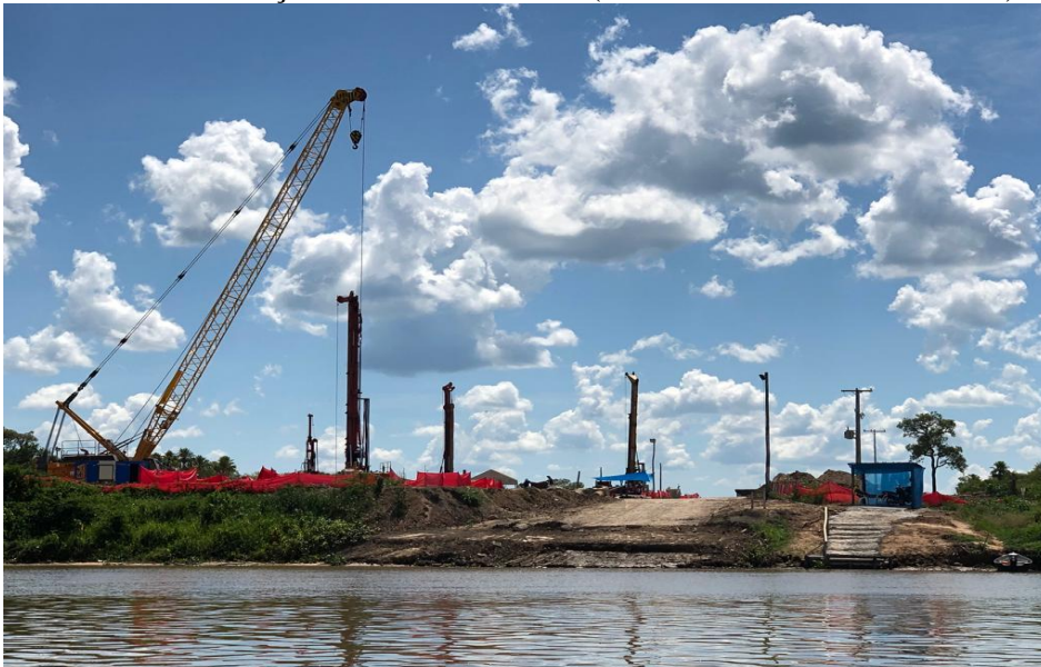
Foto 07. Construção no lado brasileiro (visita em novembro de 2022).
