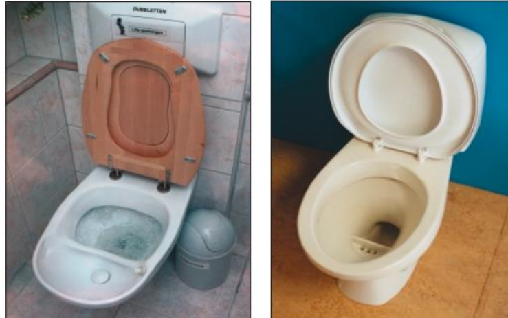
Figura 1 - Vaso com sistema separador de urina e Fezes. Fonte: JOHANSSON, 2000
