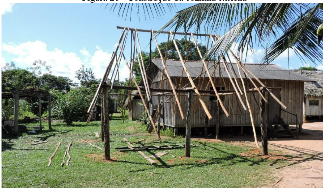
Figura 26 - Construção da cozinha externa
