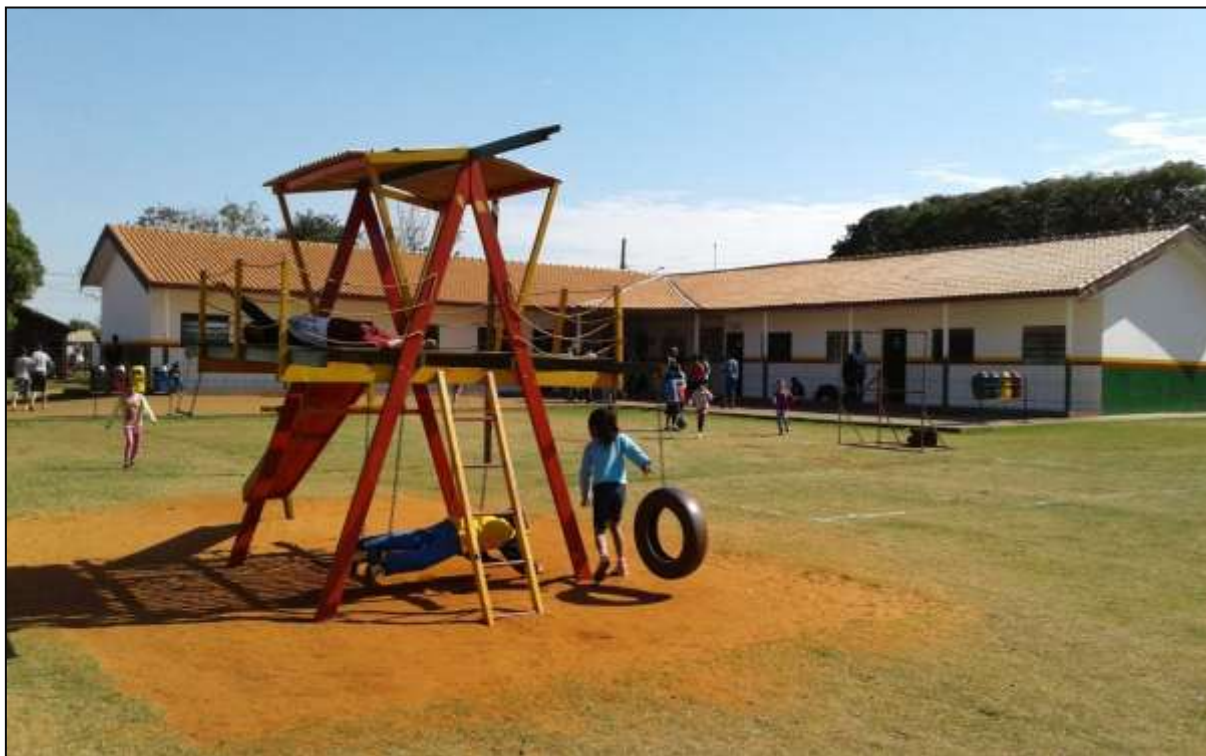
Imagem 6 - Obra concluída, Escola Indígena Cacique “João Batista Figueiredo”.
