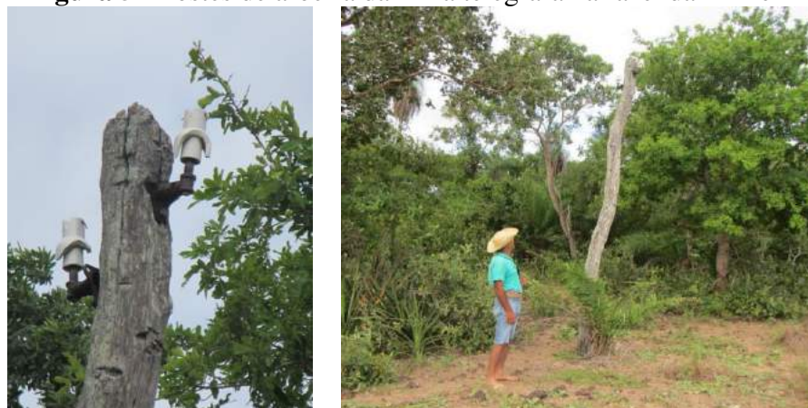
Figura 5 - Postes de aroeira da linha telégrafo na fazenda Firme
