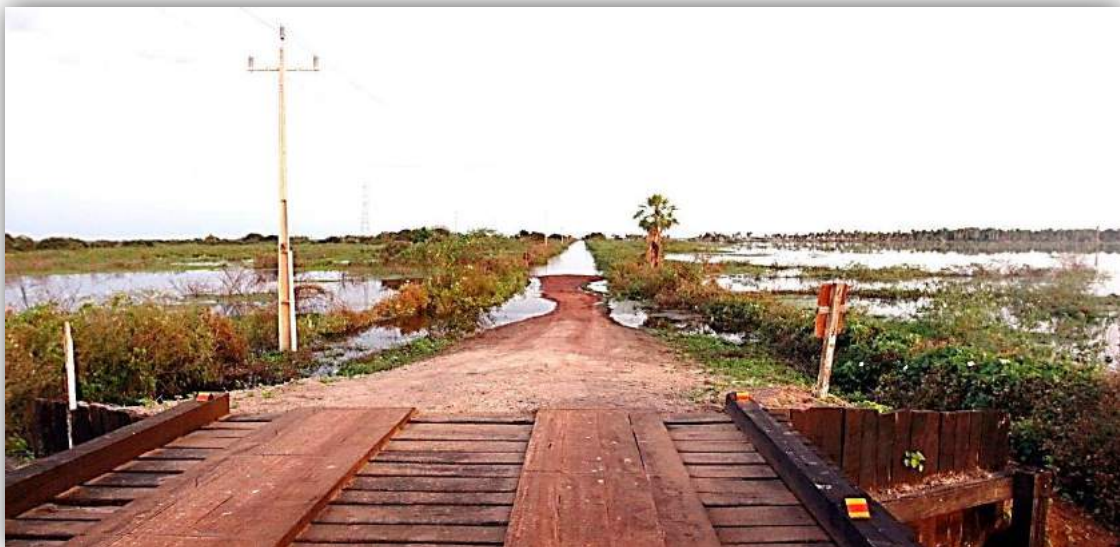
Figura 32 – Estrada-Parque Pantanal interdita pelas águas do rio Paraguai.
